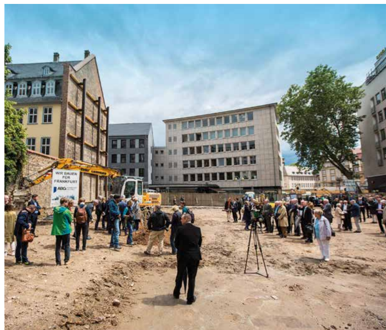
Am Großen Hirschgraben entsteht das Romantik- Museum.
