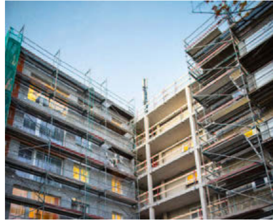
Vorbild für Europa: Sanierung in Frankfurt.
